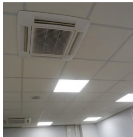
Travaux tous corps d'état
