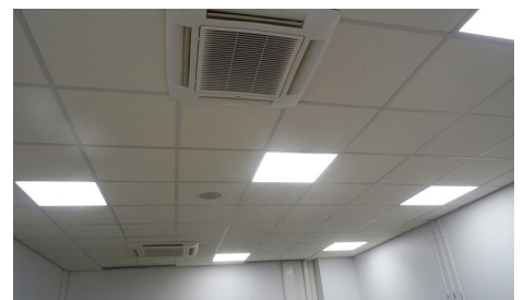
Travaux tous corps d'état
